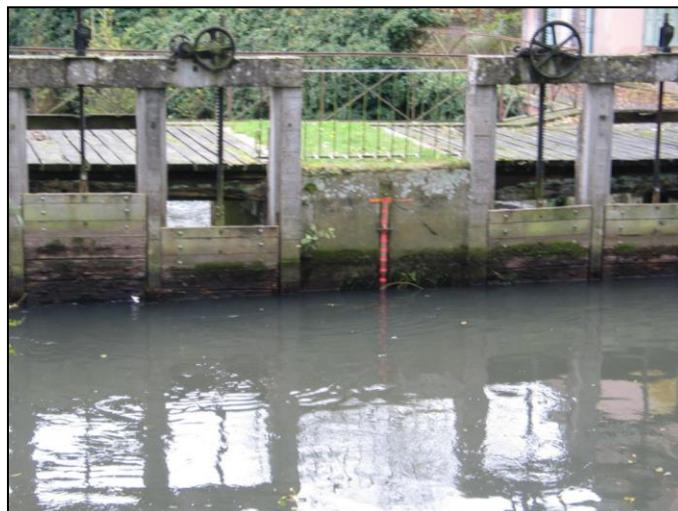
Observations : mauvais fonctionnement des pelles de vannes
