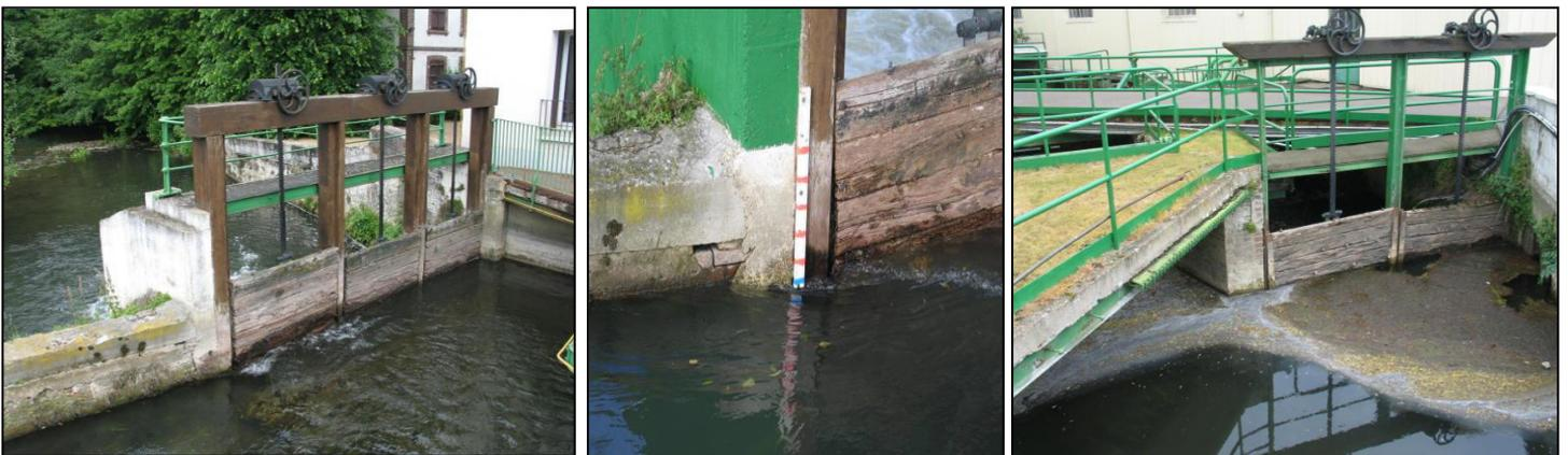
Remarque : le mécanisme de la première vanne est **Hors service**, l'ouverture doit se faire à l'aide d'un palan.
