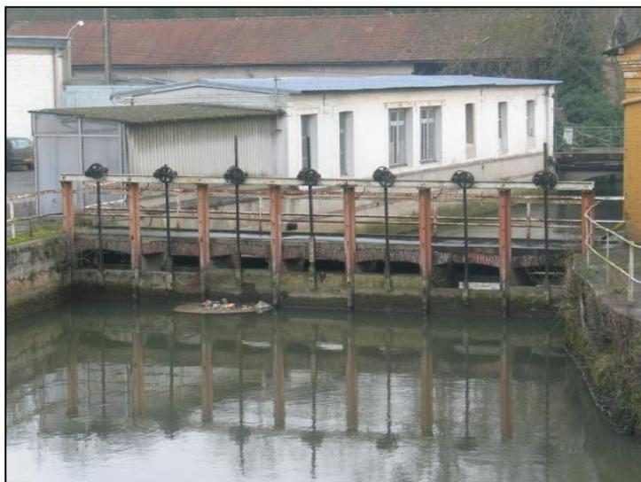
Observation : travaux d'entretien à réaliser (graissage des mécanismes, nettoyage devant le vannage, coupe d'arbustes qui gênent l'ouverture d'une pelle de vanne, retrait d'un arbre sous le pont amont) – visite du 15/10/19
