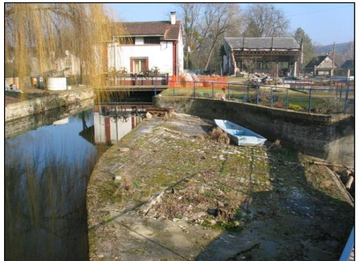
Observations : le 16/10/19, bon état de l'ouvrage de décharge amont, l'ouvrage du bras usinier présente une pelle de vanne dans un état moyen
