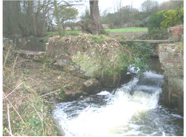
Ancien vannage d'un moulin (Moulin de Bâlines)
