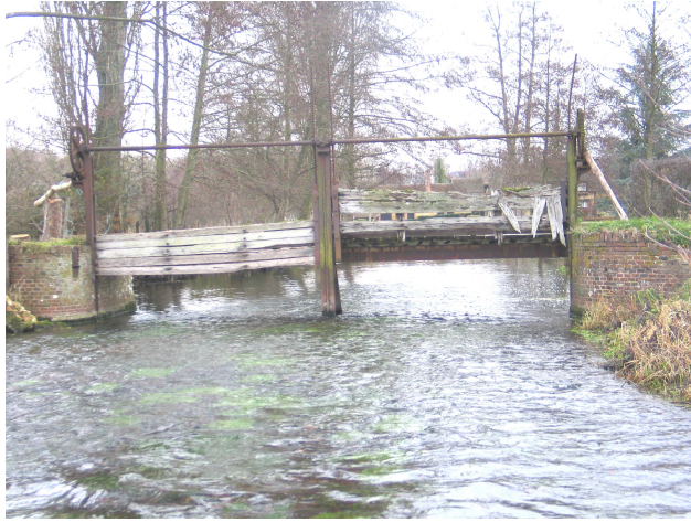
Ancien vannage servant à l'irrigation (Les Varennes)
