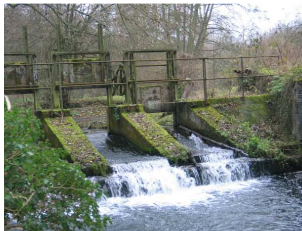
Ouvrage infranchissable (hauteur de chute) (Moulin Foulon)
