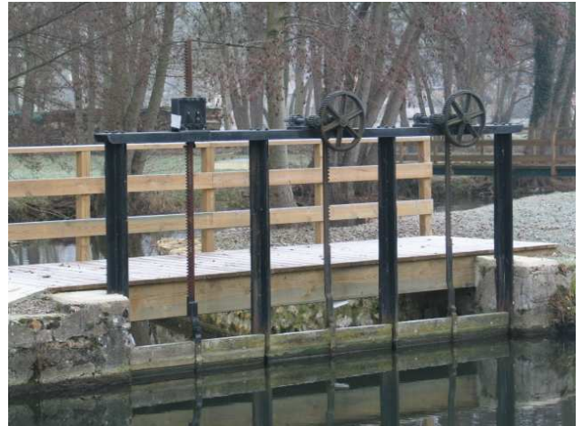
Ouvrage en bon état (Monthuley à St-Germain)
