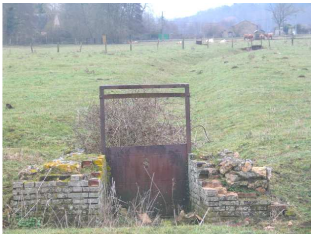
Ancien fossé et vannettes d'irrigation (les Dix Arpents à Dampierre)
